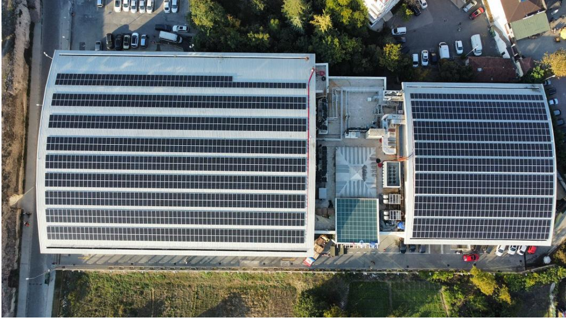
Görsel 13 Çatı PV uygulaması
