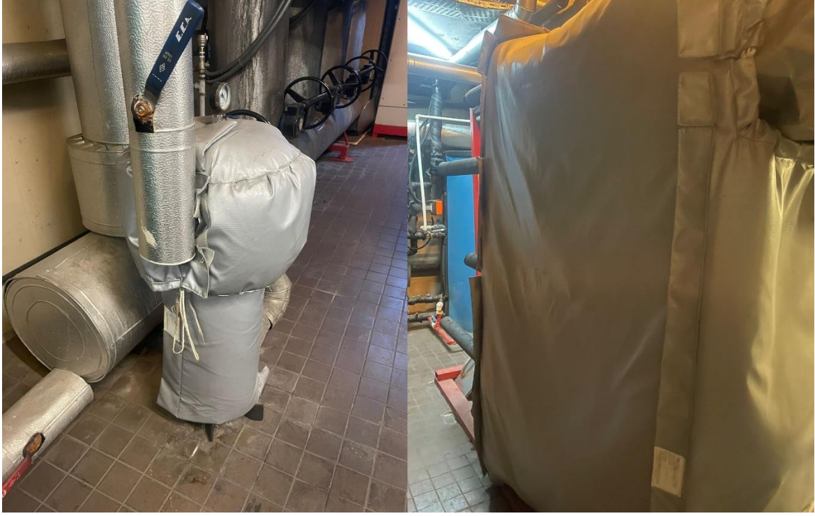
Görsel 7 Vana ceketi ve tesisat yalıtımı uygulaması
