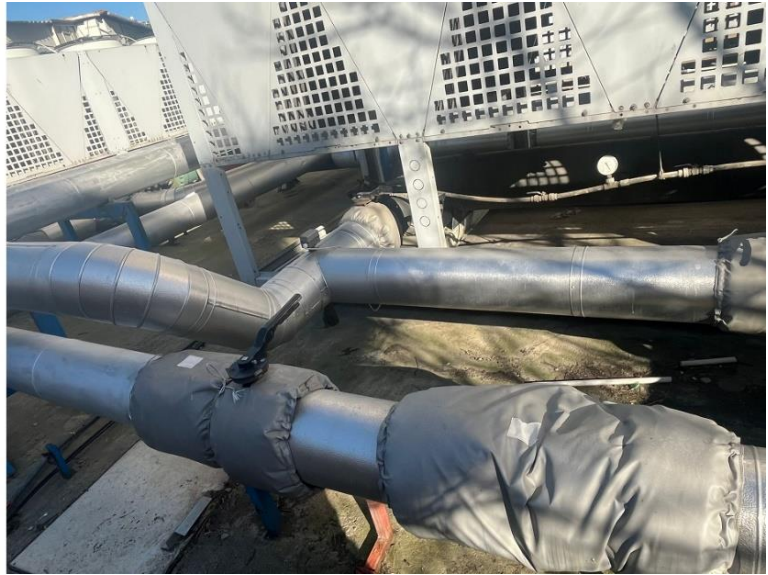
Görsel 10 Soğutma grubu modernizasyonu
