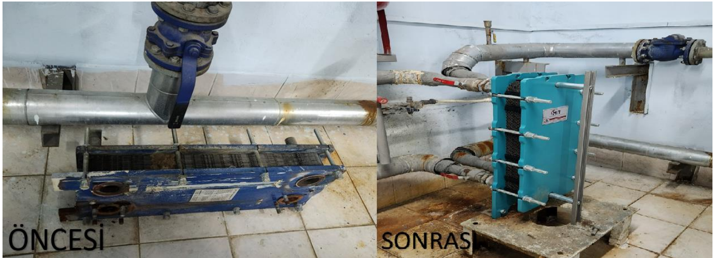
Görsel 11 Eşanjör değişimi uygulaması
